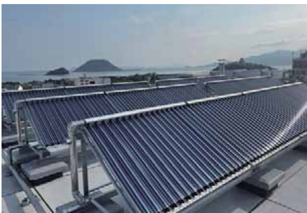
■市庁舎（佐賀県） 機種：ソラリス 型式：CPC1518 台数：32台 集熱面積：96㎡ 用途：空調補助
