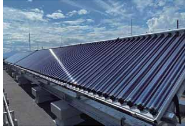
■市庁舎（岐阜県） 機種：ソラリス 型式：T-CPC1514 台数：20台 集熱面積：47㎡ 用途：空調補助
