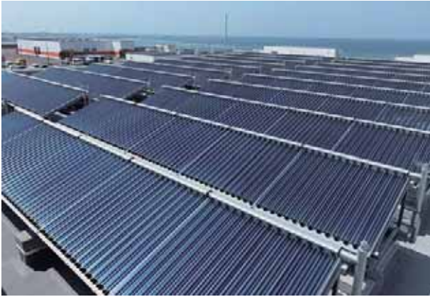
■大型商業施設（沖縄県） 機種：ソラリス 型式：T-CPC1514 台数：110台 集熱面積：256㎡ 用途：空調補助
