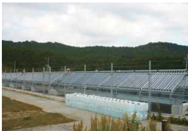
■公衆浴場（福岡県） 機種：ソラリス 型式：CPC1512 台数：180台 集熱面積：360㎡ 用途：給湯補助
