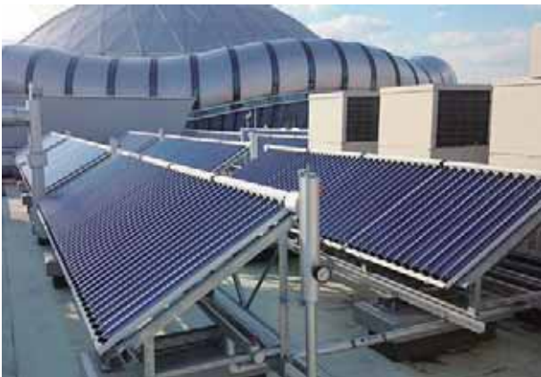
■オフィスビル（大阪府） 機種：ソラリス 型式：CPC1512 台数：40台 集熱面積：80㎡ 用途：空調補助
