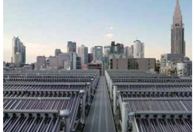
■オフィスビル（東京都） 機種：ソラリス 型式：CPC1512 台数：174台 集熱面積：348㎡ 用途：空調補助
