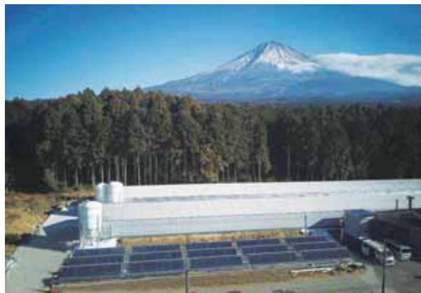
■養鶏場（静岡県） 機種：ソラリス 型式：T-CPC1514 台数：96台 集熱面積：224㎡ 用途：給湯補助
