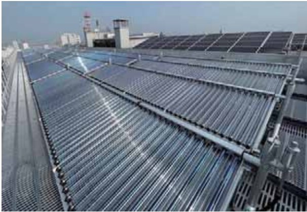
■市庁舎（山口県） 機種：ソラリス 型式：T-CPC1514 台数：163台 集熱面積：380㎡ 用途：空調補助
