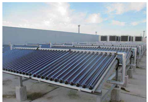
■図書館（千葉県） 機種：ソラリス 型式：CPC1512 台数：54台 集熱面積：108㎡ 用途：空調補助
