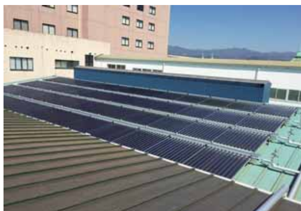
■温水プール（高知県） 機種：ソラリス 型式：CPC1512 台数：78台 集熱面積：156㎡ 用途：給湯補助
