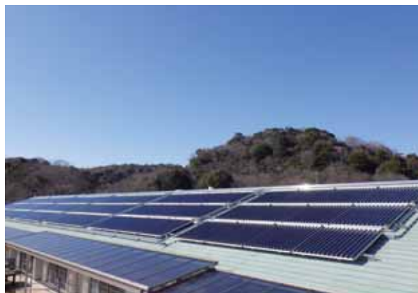
■福祉施設（山口県） 機種：ソラリス 型式：T-CPC1514 台数：104台 集熱面積：243㎡ 用途：給湯補助
